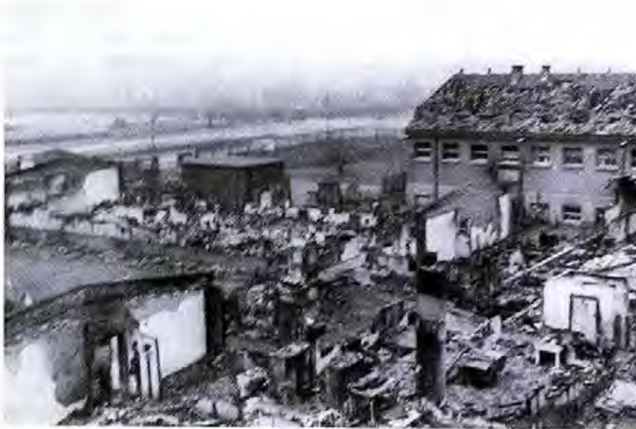
Abb. 12 Reichvitaminanstalt nach der Zerstörung durch den Luftangriff vom 4. Dezember 1943
