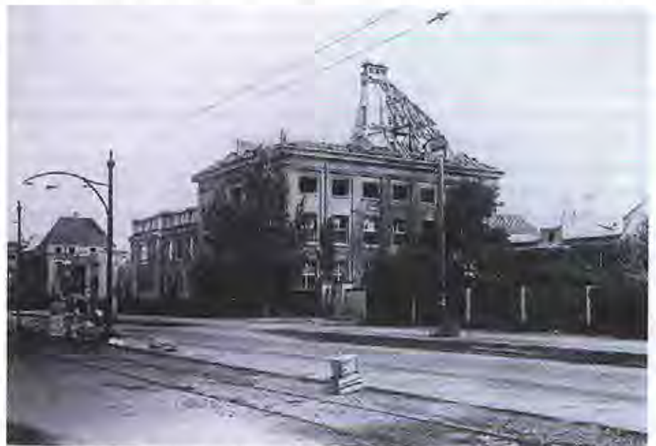
Abb. 26 Lehrgebäude der Chirurgischen Tierklinik nach der Zerstörung vom 4. Dezember 1943
