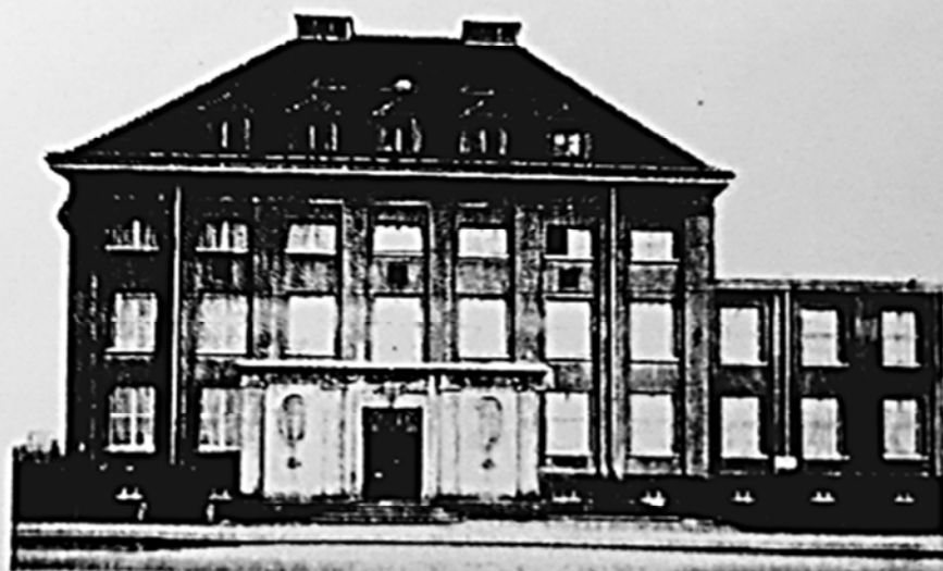
Kopfbau des 1923 fertiggestellten Veterinärinstitutes für Anatomie
