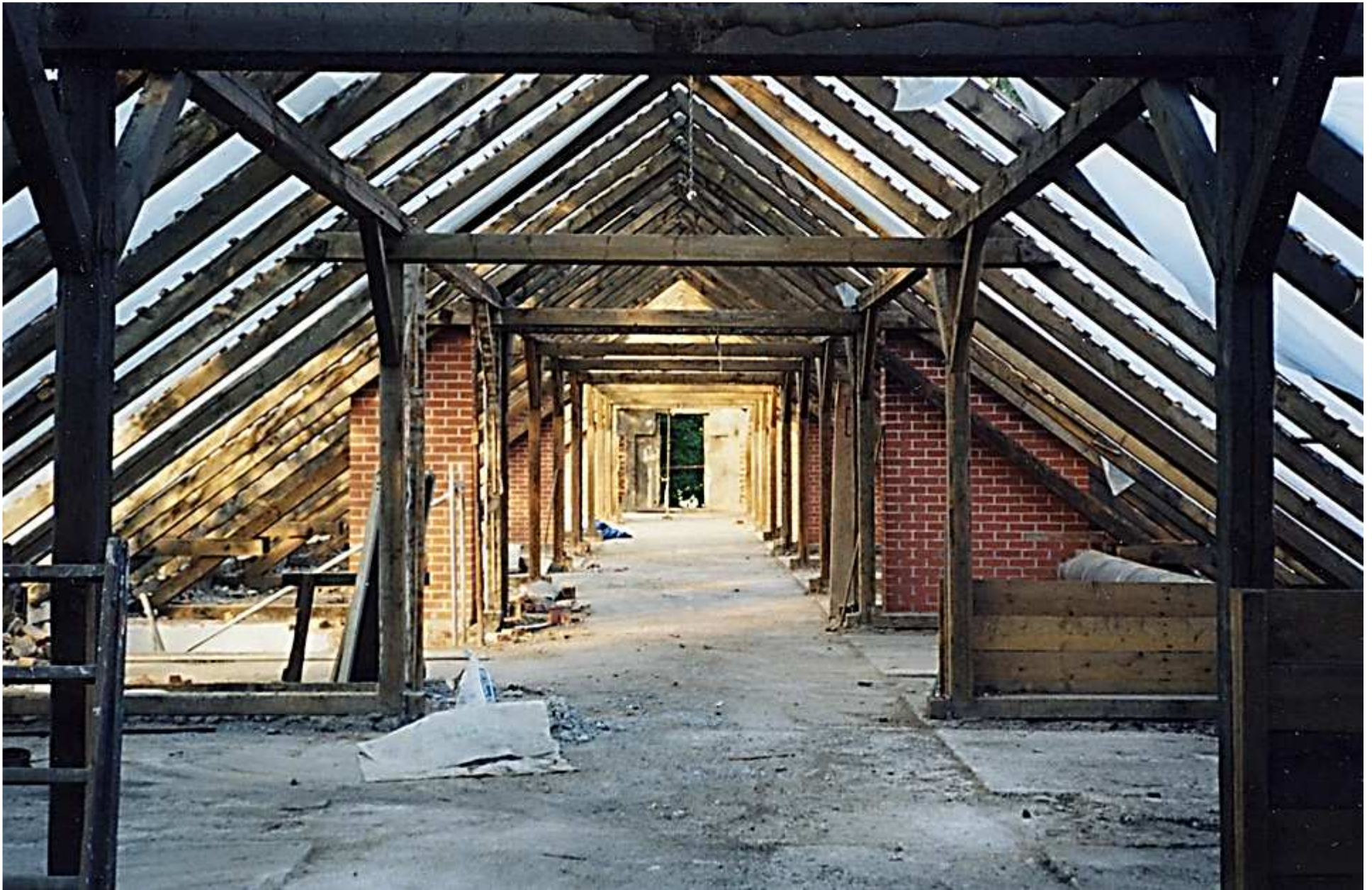
alter Dachstuhl August 1999
