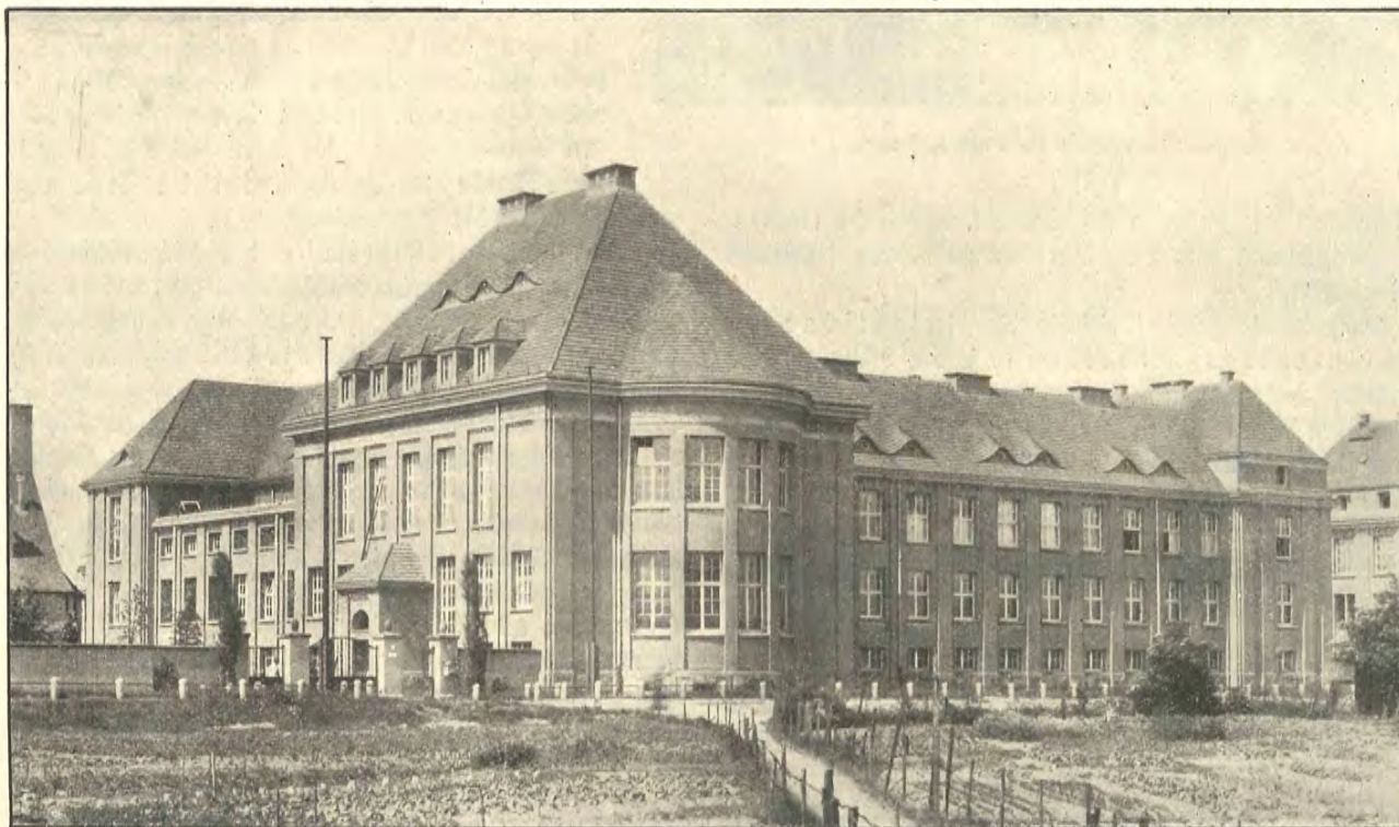
Abb. 7. Ansicht des Veterinär-Pathologischen Instituts an der Kärntner Straße.
