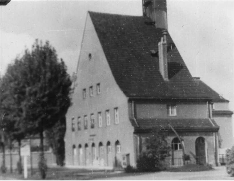
Abb. 3 Kesselhaus der Fakultät
