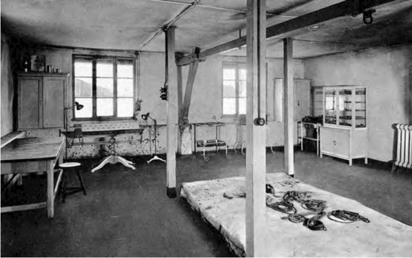
Abb. 25: Der ehemalige Übungsraum der früheren Lehrschmiede. Dieser Raum musste Richard Götze in den Anfängen der Klinik als Operations- und Demonstrationsraum dienen.
