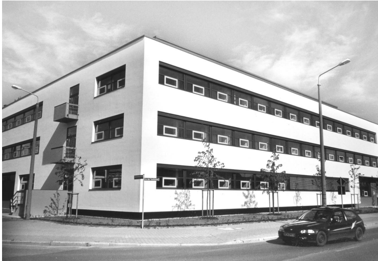
Neubau des Instituts für Lebensmittelhygiene und des Veterinär-Physiologisch-Chemischen Instituts, Mai 2002
