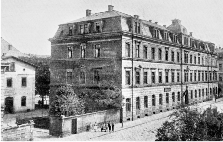
Hauptgebäude der Tierärztlichen Hochschule zu Dresden, Zirkusstraße 40, um 1890
