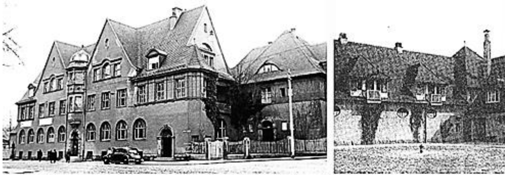
Von Hobstetter mitgeplantes Gebäude der Veterinäranstalt in der Dornburger Straße.
