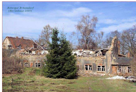
Rittergut Bräunsdorf (Herrenhaus) - Verfall und Abriss im Jahre 2005
