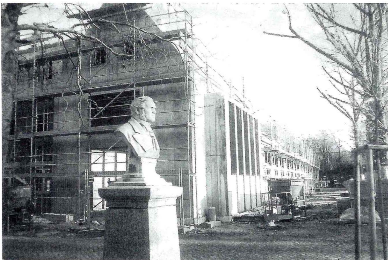
Fertigstellung des Rohbaus des 2. Klinikflügels, im Vordergrund die Büste Gottlieb Carl HAUBNERS
