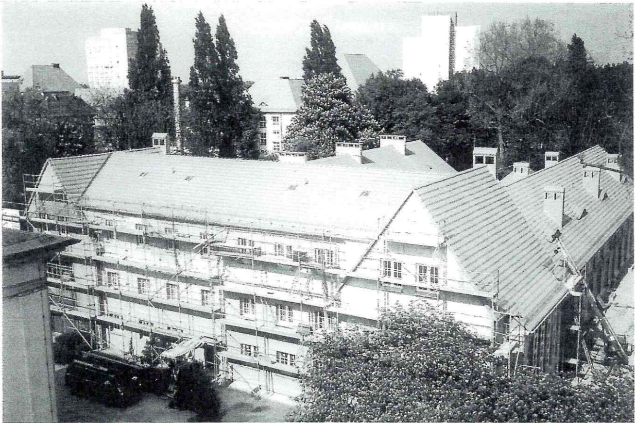
Kurz vor der Vollendung: Der Neubau des 2. Klinikflügels
