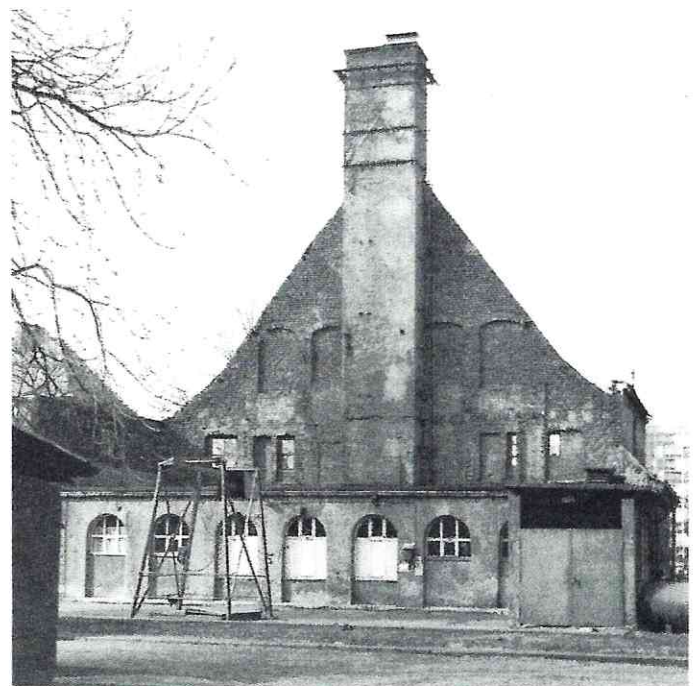
Abb. 7: Das technische Versorgungszentrum, das noch nicht wieder aufgebaut werden konnte
